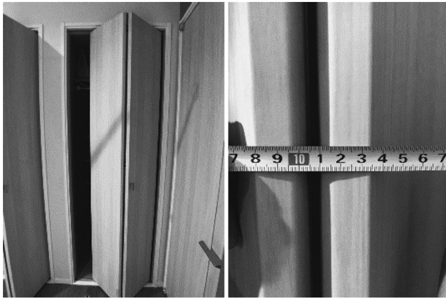
図5 折れ戸タイプの開閉式ドア（左），本児の指が挟まっていたドアの中央部分（右）
