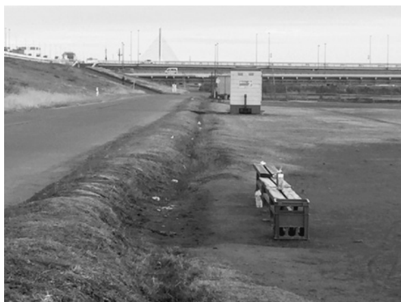
図1 実際に足を取られ転倒したあたり。側溝はすべてのグラウンドの一塁線方向・三塁線方向に掘られている。深さや幅は様々でグラウンドから歩いていったときの障害物はない。
